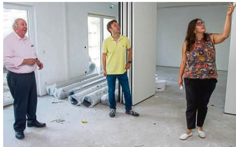
Heiko Mark (links) und Lara Garcia Marschall informieren den Bundestagsabgeordneten Jens Zimmermann über die Bauarbeiten im Hotel Elysee. FOTO: HAMPE
