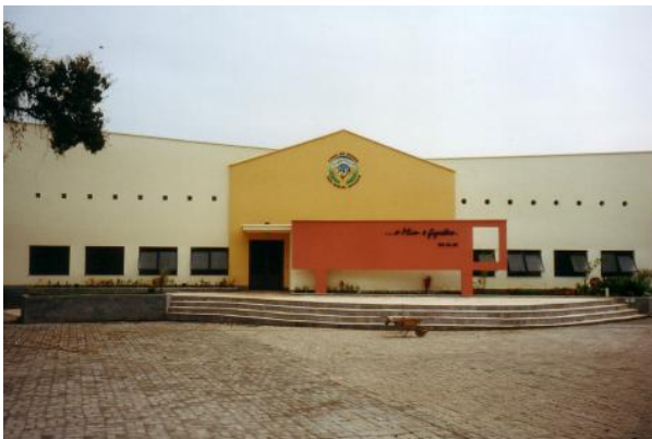
Die neue Halle
