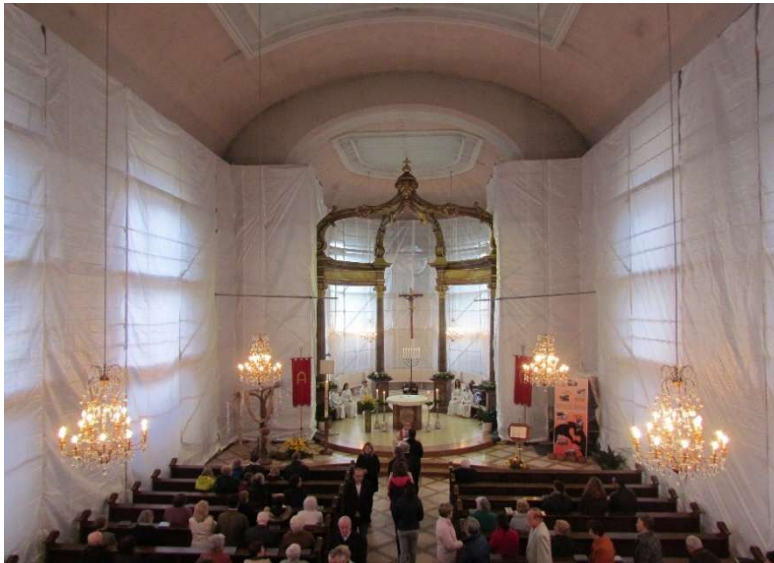
Bild 54 : Planen als Schutz vor Stuckablösungen 2016
