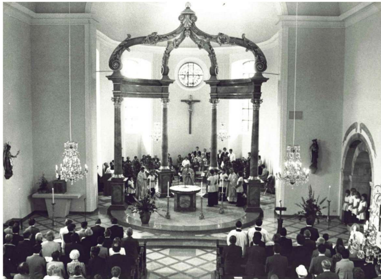
Bild 52 : Kirchenschiff nach der Innensanierung 1978
