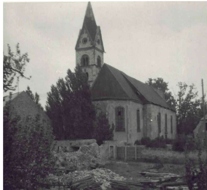
Bild 34 : Notdach auf dem Kirchenschiff
