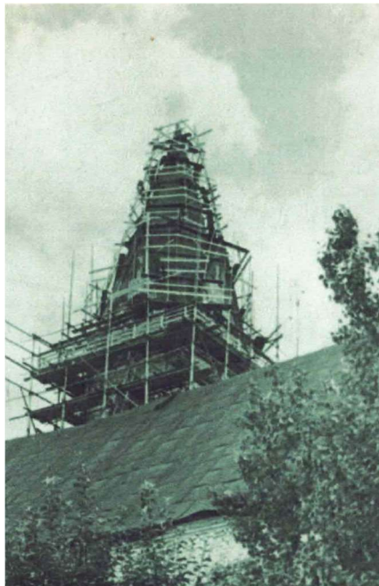
Bild 33 : Sicherung des Turms
