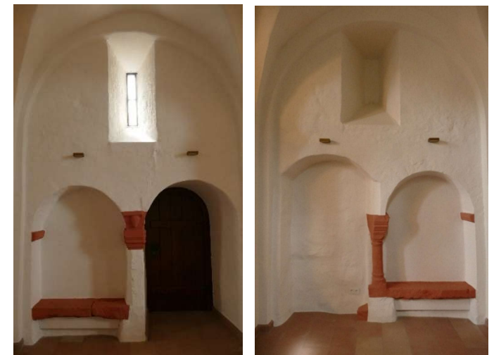
Bilder 7 und 7a : Sitznischen im Turmuntergeschoss
