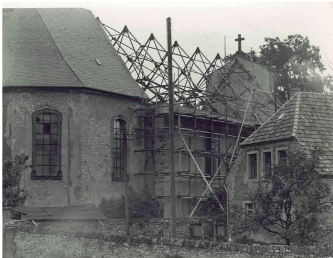
Bild 42 : Dachkonstruktion aus Stahlträgern 1950
