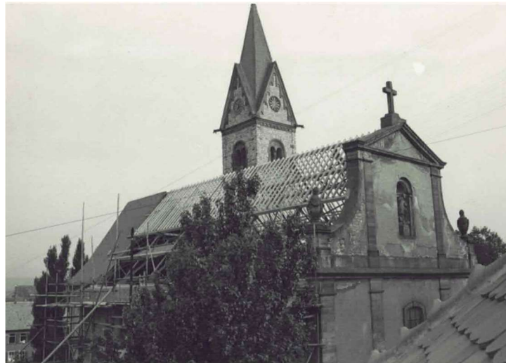
Bild 43 : Dachstuhl als Holzkonstruktion 1950
