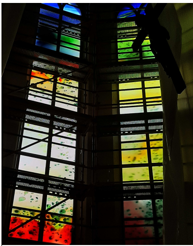
Vorhang auf: Ein erster Blick noch mit Gerüst
