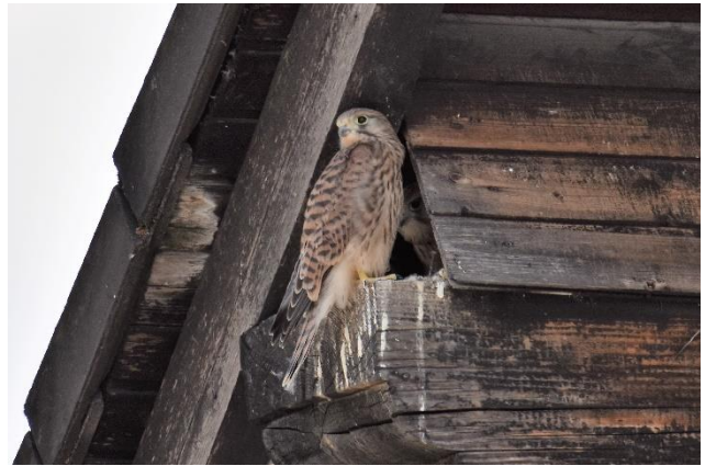
Turmfalkebrut auf Dachbalken
