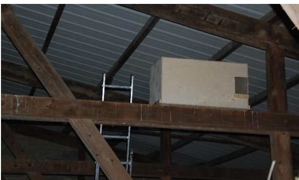
Und ein Schleiereulenkasten musste neu gebaut werden. Im alten Kasten fanden früher viele Bruten statt
