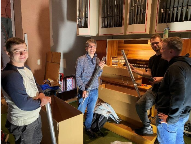
Bild 2: Der Abbau der Orgel hat begonnen.
