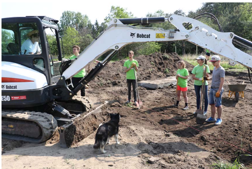
Baggern und schaufeln ...
