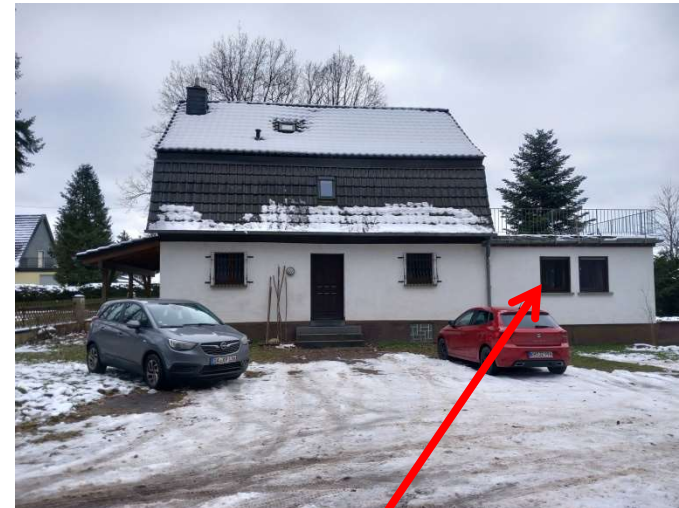
Anbau mit Gemeinschaftsraum und Schwimmbad im Keller
