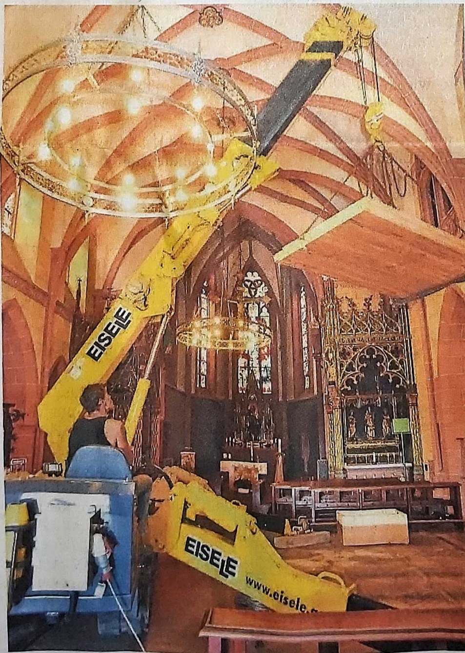
Der Kran in der Rochuskapelle ist ein notwendiges Hilfsmittel, um die Einzelteile des Instruments nach unten zu bringen.
