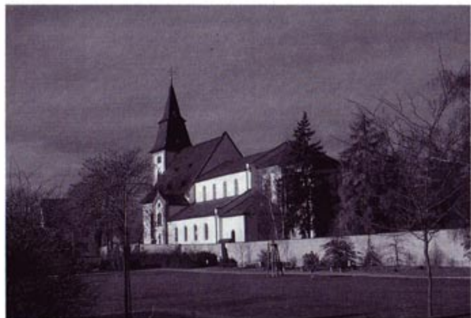
Südsansicht der kath. Pfarrkirche Bingen-Büdesheim
