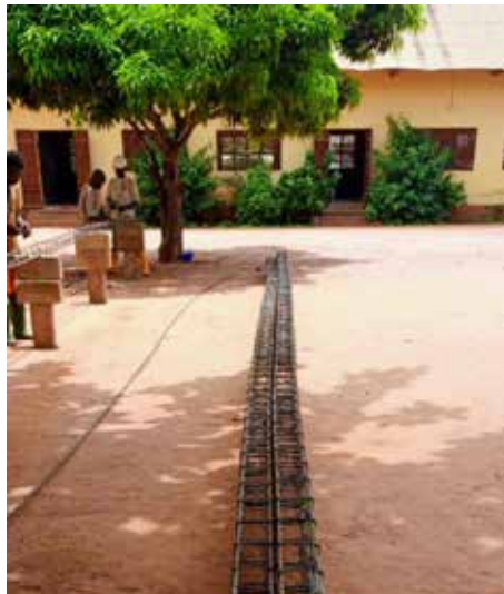
Die Eiseneinlagen werden gefertigt
