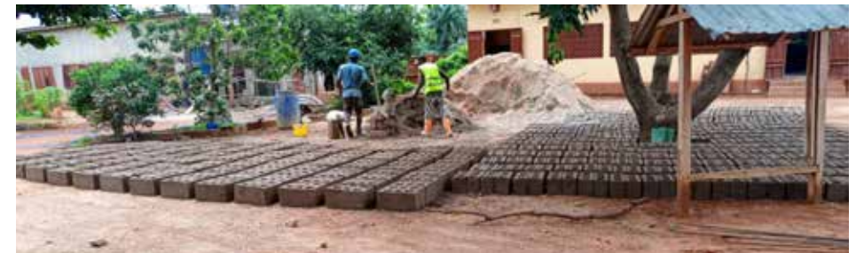
Bausteine werden vor Ort gefertigt
