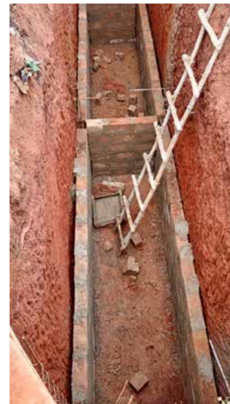
Die Toilettengrube wird gemauert
