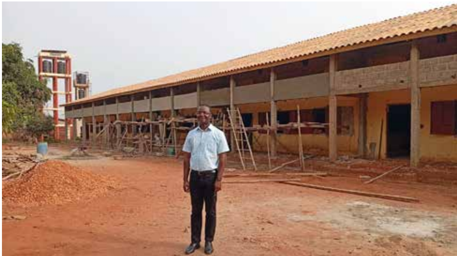
Kaplan Martin Djegbate (Amtsbruder von Levi Hinglo) vor dem in Renovierung befindlichen Gebäude (im Januar 26)
