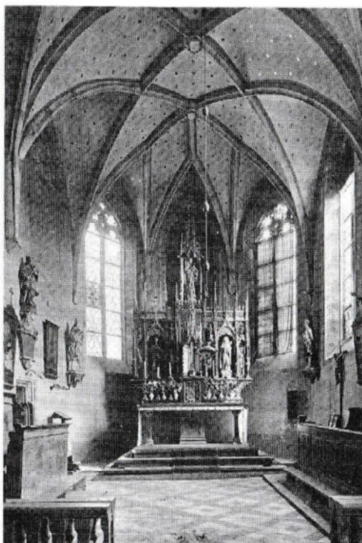
Der Chorraum von 1492, der älteste und wertvollste Teil der Kirche, er mußte zusammen mit der Sakristei vom Zehntherrn unterhalten werden.
