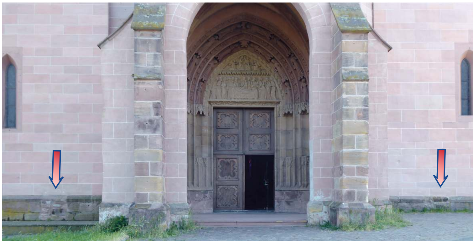
Hauptportal der Liebfrauenkirche. Rechts und links sind die vermauerten Öffnungen erkennbar.
