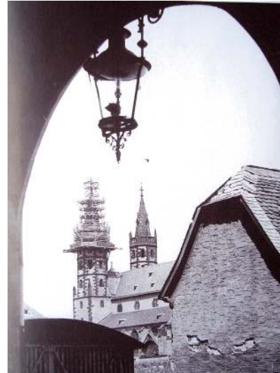
Ein neues Dach für den Südturm
