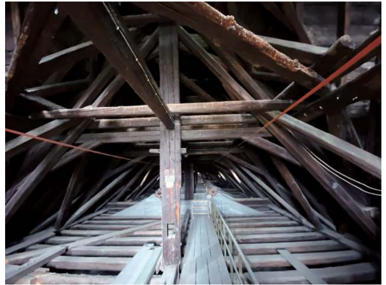
Abb. 5: Blick in den Dachstuhl über dem Hauptschiff; Foto: Britta Hedtke 2023
