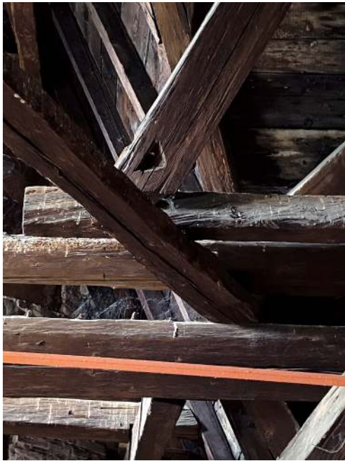
Abb. 3: Worms, Liebfrauenkirche, Dachstuhl über dem Hauptschiff, sog. „Flößerauge“ oder „Wiedloch“; Foto: Britta Hedtke 2023
