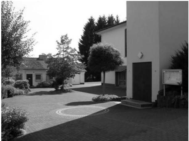
Pfarrhof und Pfarrhaus. Vorne der ehemalige Eingang durch den Glockenturm.
